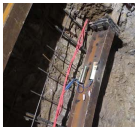
图 6 初支内力监测试验布设情况
