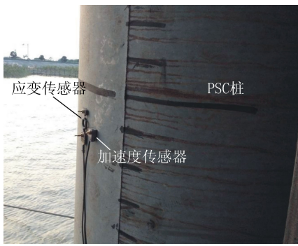
图1 现场高应变检测传感器安装
