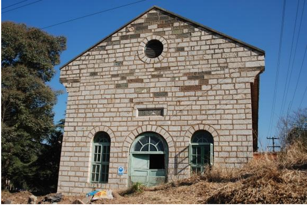
一发电车间侧立面
